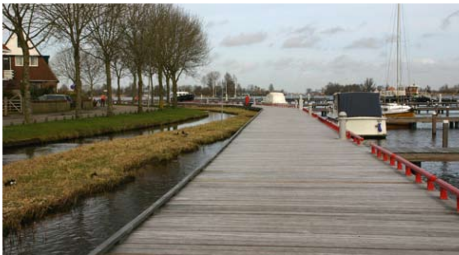
Grou: wandelsteiger bij de passantenhaven
