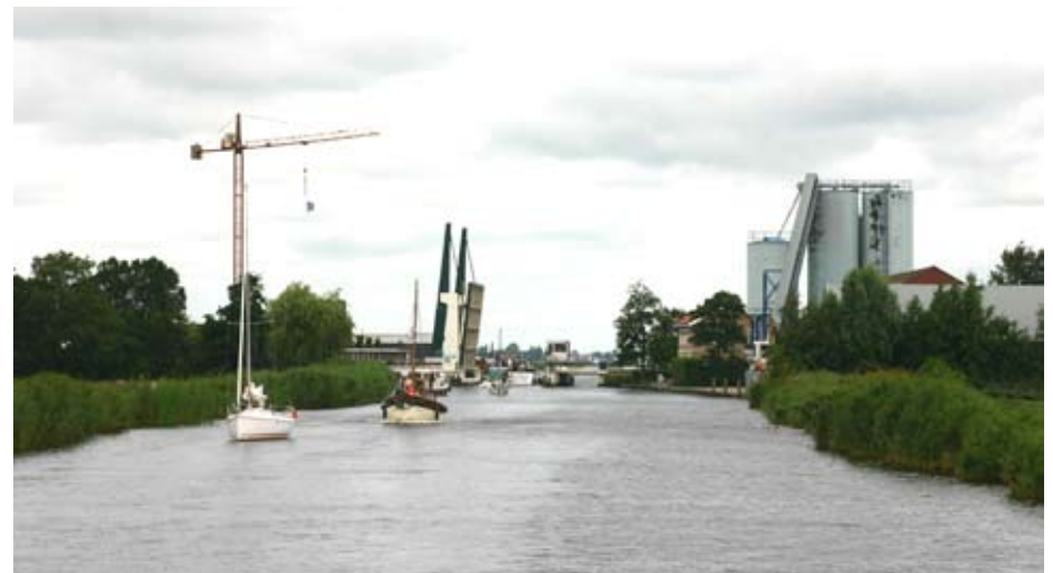
de brug bij Osingahuizen vanaf het water
